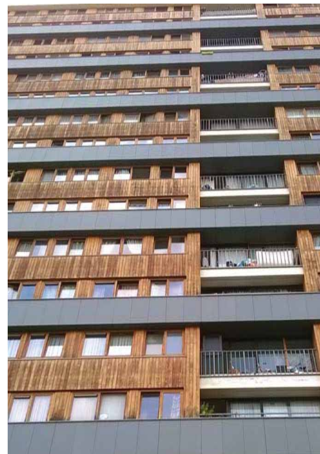
| ZOOM SUR LA FAÇADE DU BLOC ESSEGHEM 1 DU FOYER JETTOIS source : photographie ARTER ©
