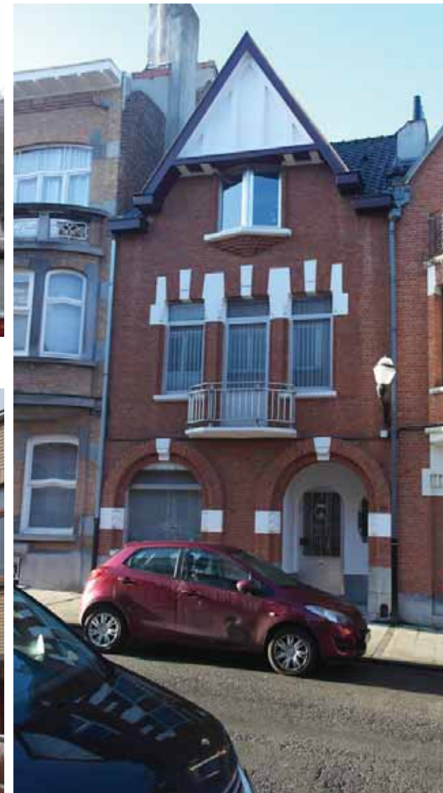
| 79, RUE DES AUGUSTINES source : photographie ARTER ©
