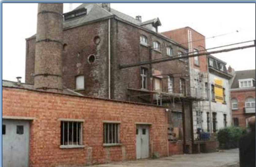
Intérieur du site Wayland – situation avant 1993
